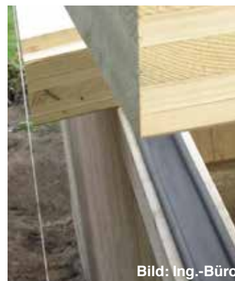
Abb. 60 Beim Aufsetzen der Deckenelemente wird die Luftdichtung durch das Einlegen eines speziellen Dichtungsprofils vorbereitet.
