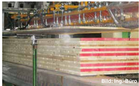
Abb. 9 Kreuzweises Auslegen der Brettlagen und Leimauftrag. Danach folgt der Pressvorgang.
