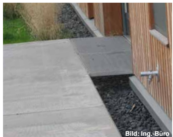
Abb. 63 Rampenartige Ausbildung von Podesten. Überquerung zur Eingangstür mit Gitterrosten.
