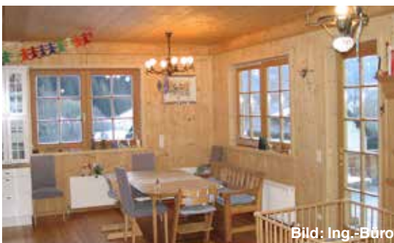
Abb. 52 Es ist möglich, auf eine Innenbekleidung zu verzichten und das Brettsperrholz raumseitig sichtbar zu belassen. Hier im Bild mit der Oberfläche von natürlichem Fichtenholz, bis hin z. B. zu einer weißen Lasur.
