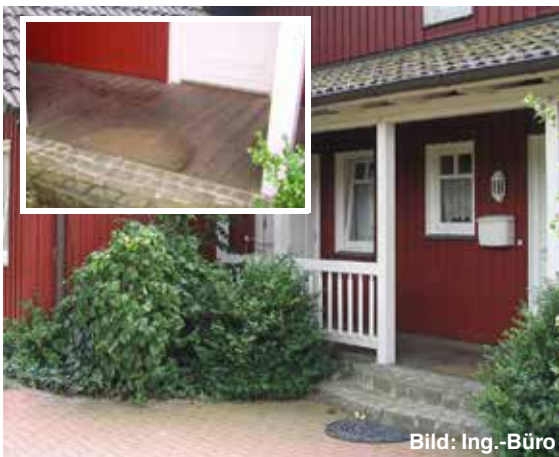
Abb. 64 Podest als Holzbelag auf Unterkonstruktion
