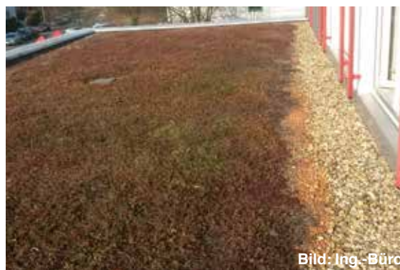
Abb. 49 Dächer mit Aufdachdämmung sind nutzbar und trotzdem bezüglich des Feuchteschutzes der Konstruktion sicher, hier mit extensiver Begrünung.
