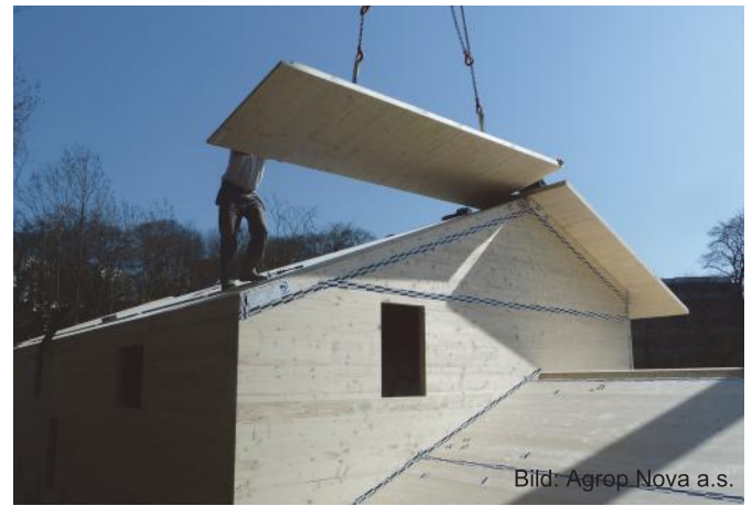
Abb. 79: Selbst Dächer können hergestellt werden.
