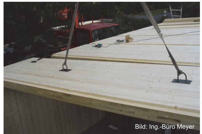
Abb. 80: Eine große Zukunft haben die Brettsperreholzelemente für die horizontalen Bauteile wie Flachdächer und Geschossdecken. Die Bauzeiten verkürzen sich um Wochen.
