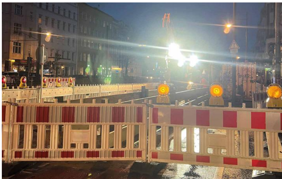
Foto: BG BAU
